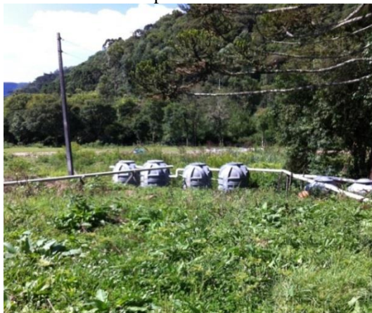
Figura 6. Filtros utilizados no tratamento da água residual do entreposto.
