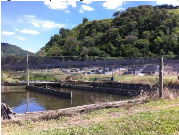
Figura 4. Tanque de engorda maior (fluxo contínuo).
