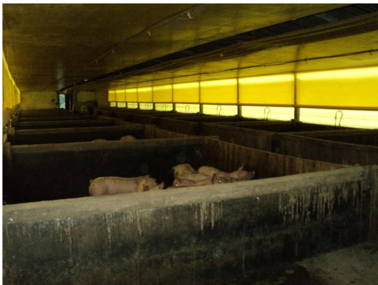
Figura 4 - Galpão dos grupos WF e CC3 nas fases de crescimento e terminação com cortinado duplo, piso e divisórias de concreto (padrão da cooperativa), instalação mais antiga que a do convencional.
