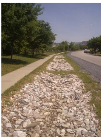
Figura 16 - Trincheira de infiltração
