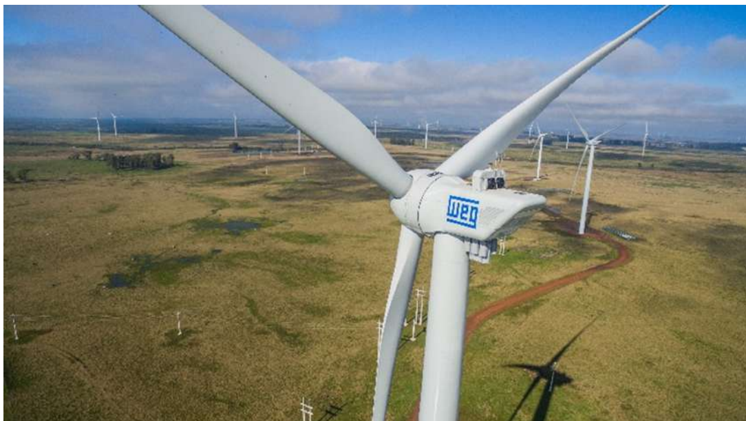
Figura 19 – Parque de geração eólico com AGW 110/2.1.
