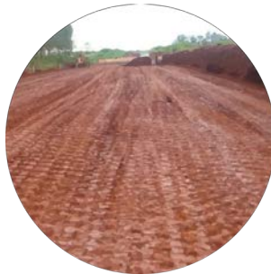
Compactação dos solos
