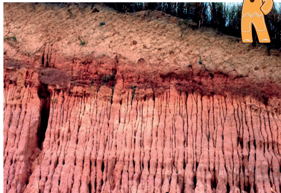
Rede de ravinas em talude, em corte de estrada, no município de Açailândia, no Estado do Maranhão
