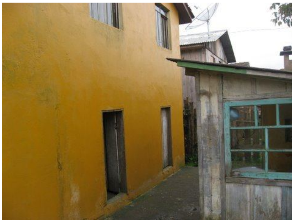
Figura 6 - Casa 03, fundos, com porões e edícula.
