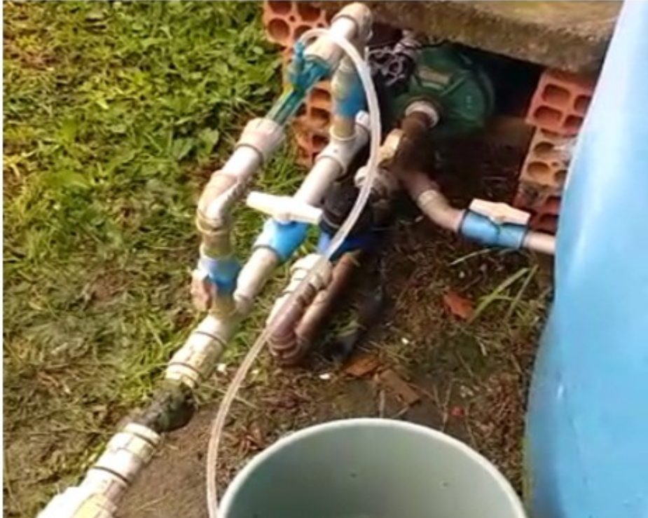
Figura 4 - Bomba hidráulica utilizada para irrigação e fertirrigação, anexada ao reservatório, com balde contendo solução nutritiva durante a realização de uma fertirrigação. CAV/UDESC, Lages (SC), 2019
