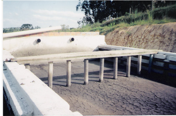
Figura 1. Tanque de drenagem de esterco empregado em granja de produção de suínos do município de Rio do Sul SC
