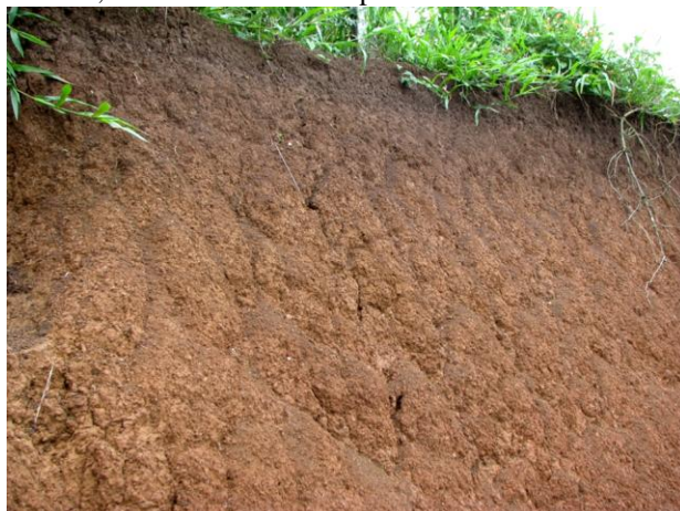
Figura 4 - P4/NB PS - Nitossolo Bruno Distrófico húmico latossólico rúbico, com caráter retrátil, localizado no município de Ponte Serrada/SC.
