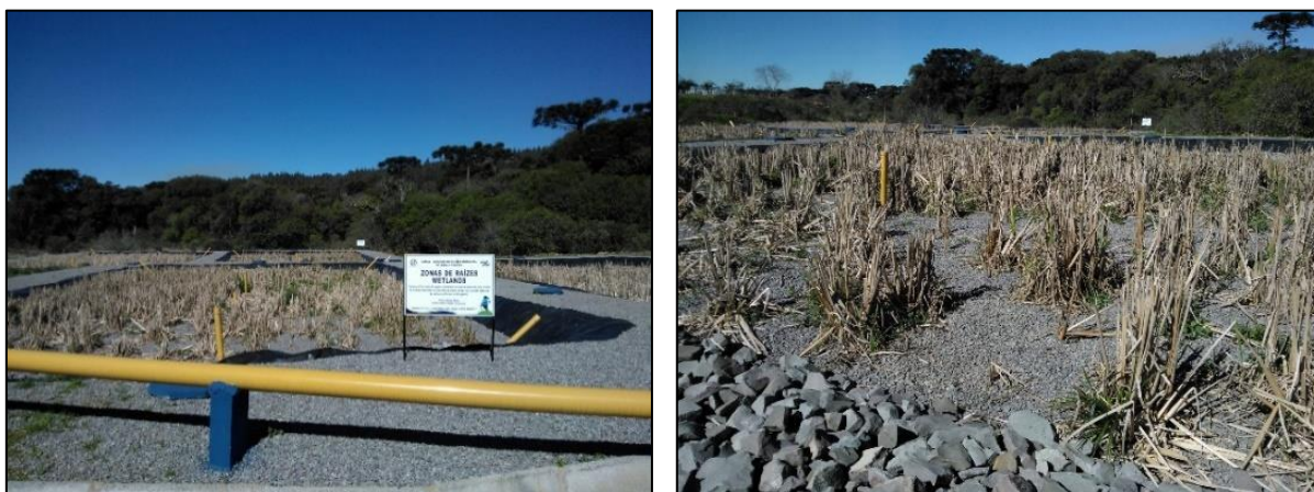
Figura 4.1 - Distribuição das plantas no maciço filtrante e o efeito do frio durante a estação do inverno.
