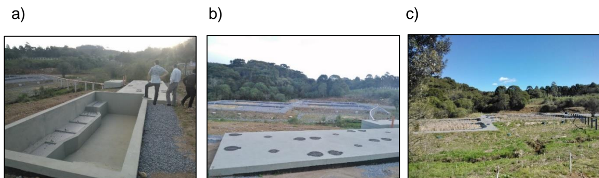
Figura 3.2 - Etapas do tratamento do esgoto na ETE “Bacia D”, Campos Novos-SC. a) tratamento preliminar, b) filtro anaeróbio e c) wetland construído.
