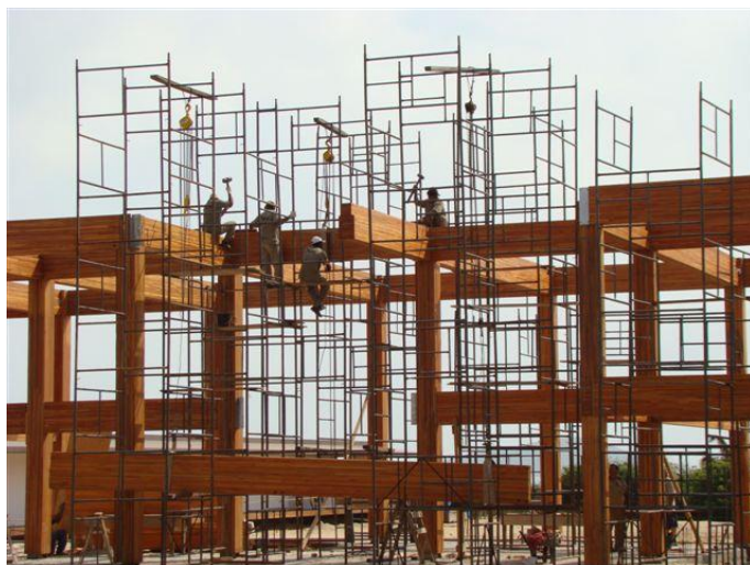
Figura 7 - Construção de grande porte em MLC. Residência em Búzios – RJ
