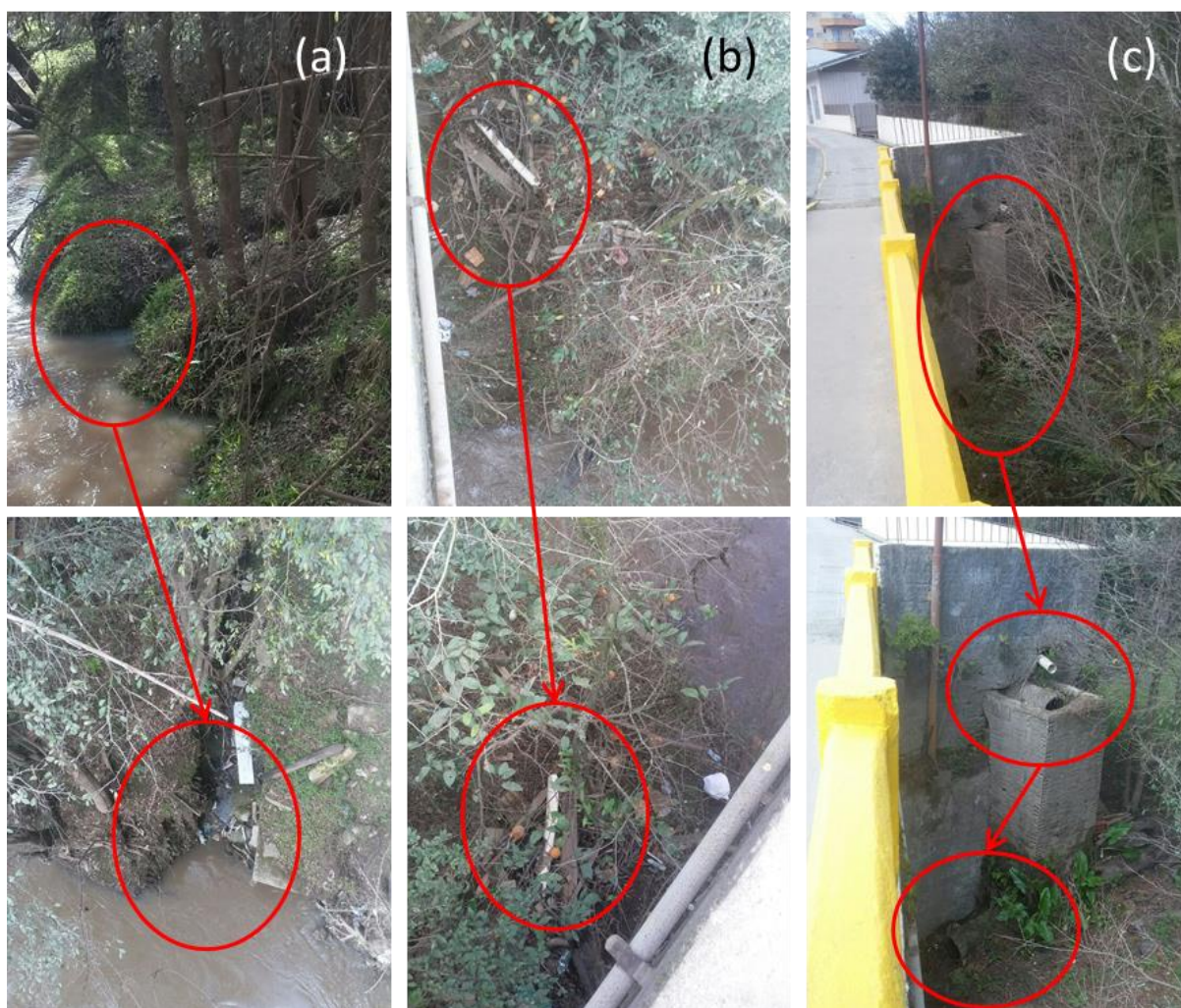
Figura 24. Pontos 24(a), 25(b) e 26(c), despejo direto de efluentes no corpo hídrico.
