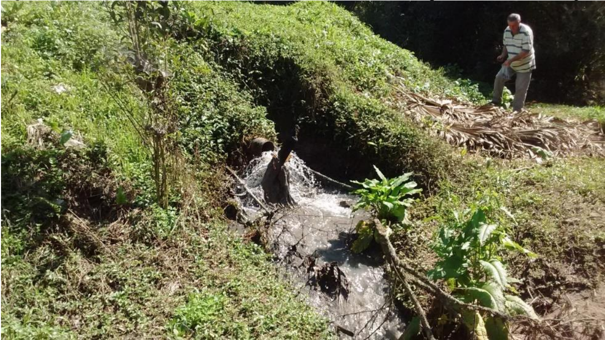
Figura 7 - Local 16 em área urbana, com visível vazamento na rede pública de coleta de esgoto.
