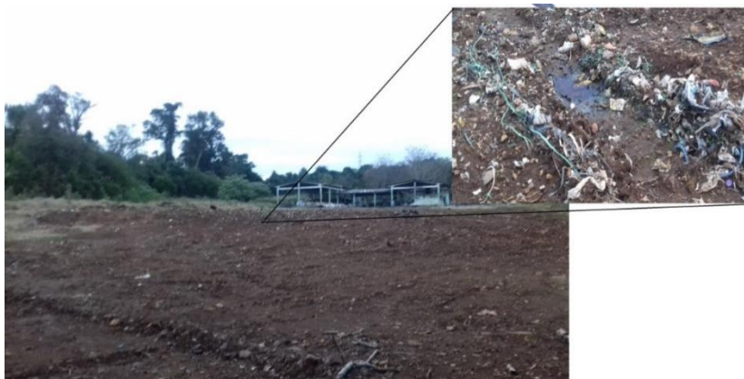
Figura 2: Aterramento realizado após a desativação da área
