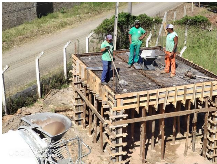
Figura 26- Construção do novo módulo para tratamento do esgoto sanitário.
