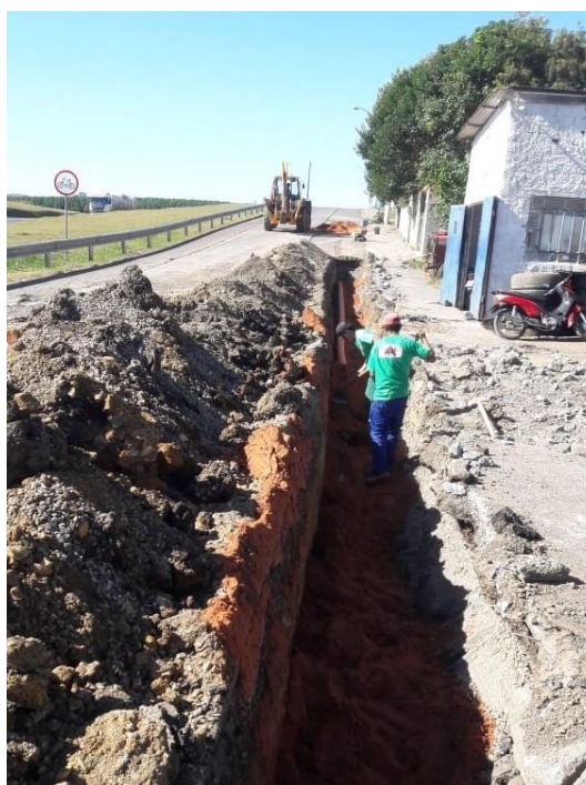
Figura 28 - Obras de implantação da rede de esgoto na marginal da BR 282.
