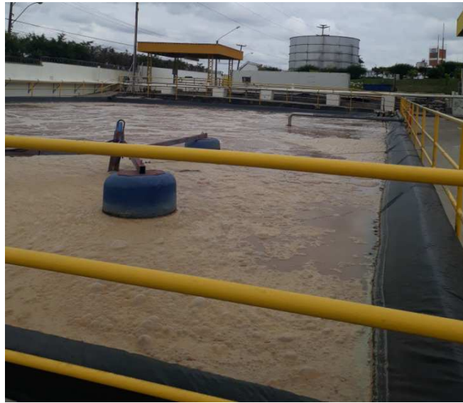
Figura 5 - Tanque de lodos ativados em uma indústria de beneficiamento de carne de frango. Fonte: Elaborado pelo autor, 2018.
