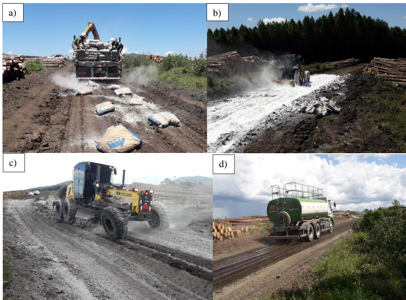
Figura 10. Construção do trecho experimental com os estabilizantes químicos. a) Distribuição da cal dolomítica na parcela. b) Homogeneização no leito da estrada com grade de discos. c) Regularização da estrada com motoniveladora. d) Umedecimento da parcela para simulação de tráfego.
