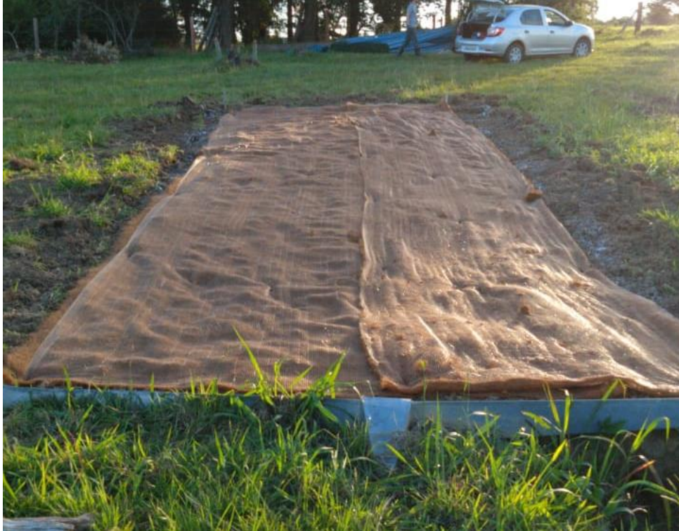
Figura 9: Parcela com biomanta colocada na superfície do solo com uma sobreposição mínima de 30 cm sobre panos na área experimental do Setor de Conservação do Solo, do Centro de Ciências Agroveterinárias – CAV, campus da Universidade do Estado de Santa Catarina – UDESC.
