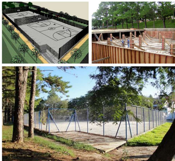
Figura 24 - Exemplo de execução de reservatório de retenção.
