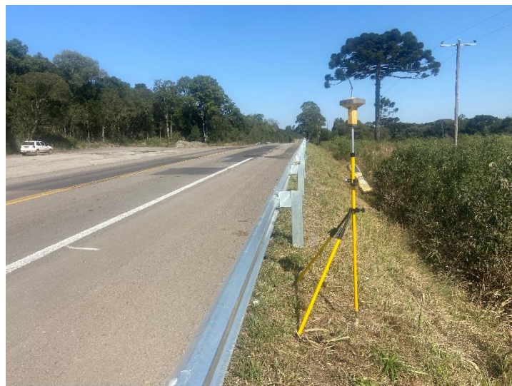
Figura 43 – Demarcação de pontos de apoio
