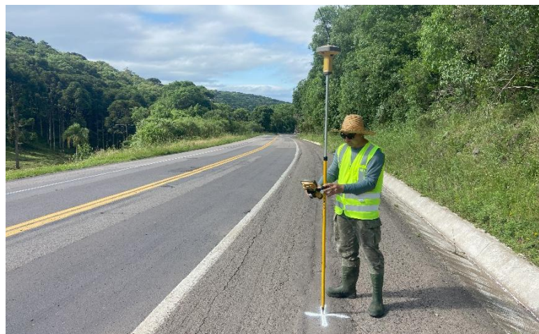
Figura 24 – Dimensão da pista de rolagem da rodovia
