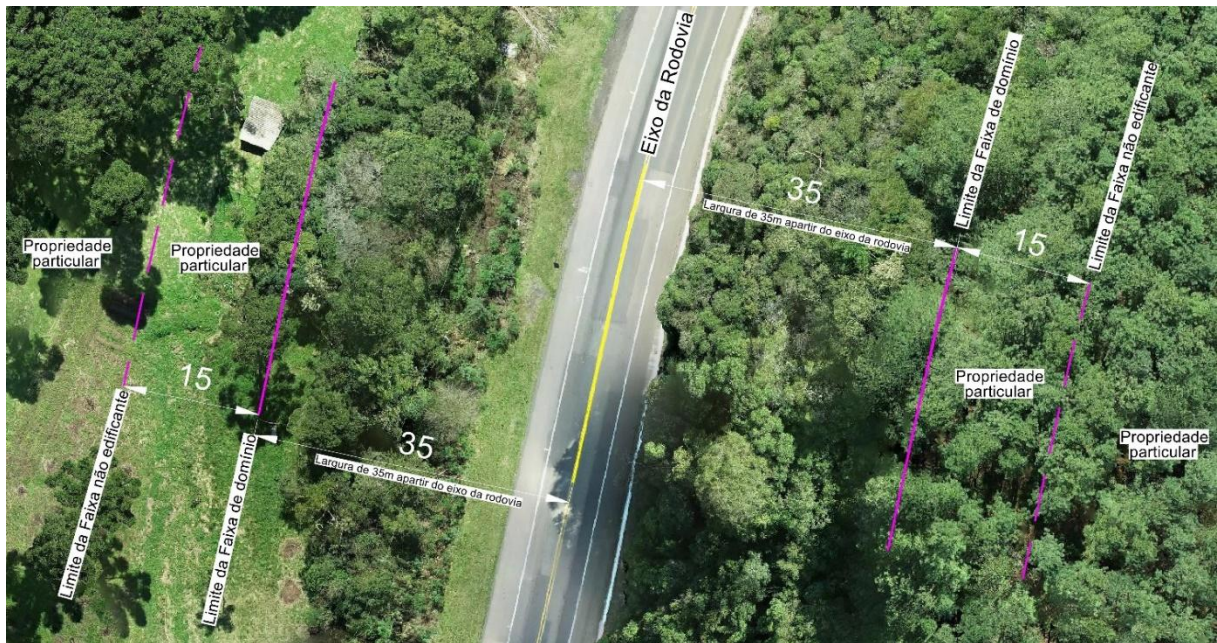
Figura 23 – Largura da faixa de domínio no trecho da rodovia analisado
