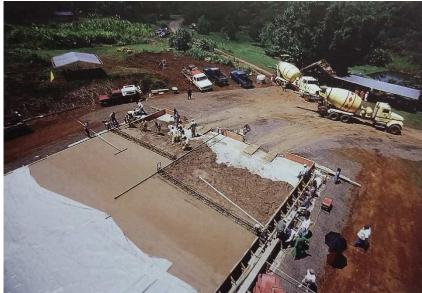
Figura 4 - Lançamento e acabamento do concreto com alto teor de cinza volante.
