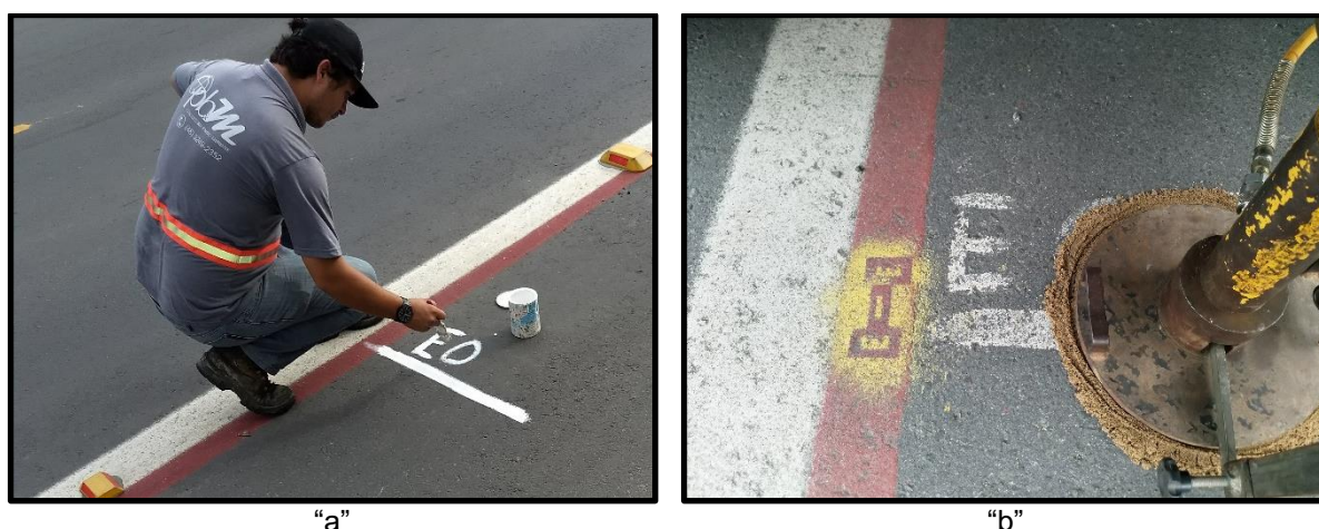
Figura 15 – Marcação das estações de ensaio (segmento 2)
