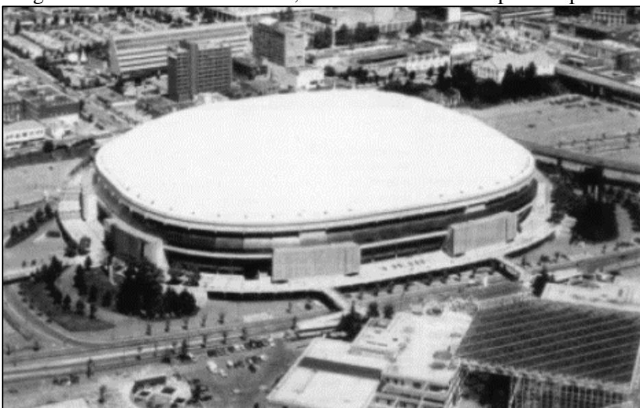
Figura 8: Estádio de Vancouver, Canadá - Estrutura Suportada pelo Ar
