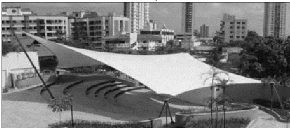
Figura 4: Memorial dos Povos, Belém do Pará – Estrutura na Forma de Paraboloides Hiperbólicos
