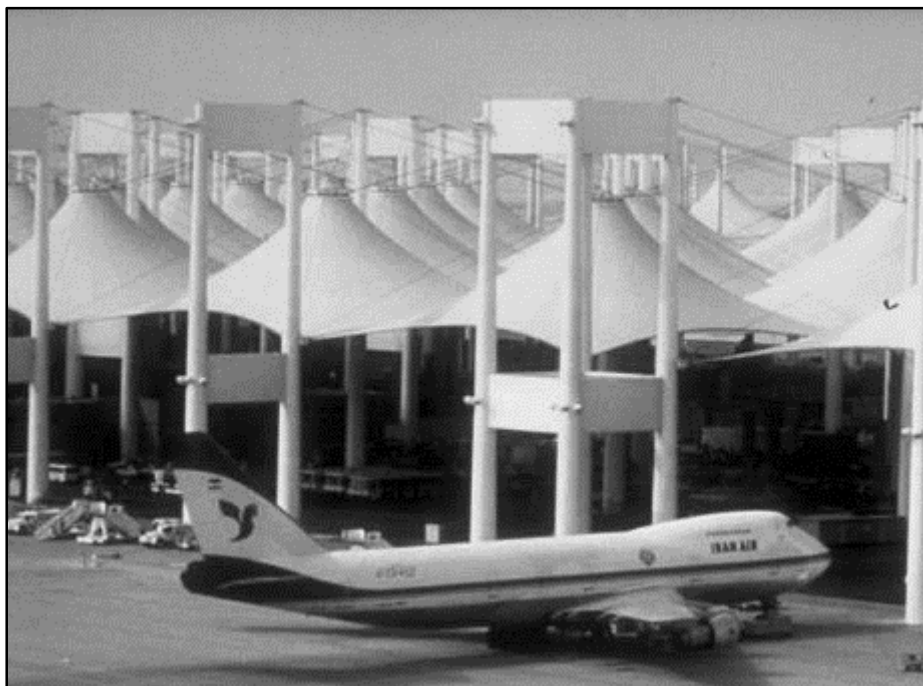
Figura 5: Hajj Terminal, Arábia Saudita – Estrutura com Superfície Gerada entre Anéis
