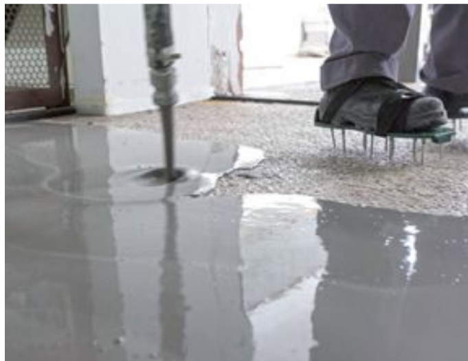
Figura 2 - Aplicação da argamassa autonivelante
