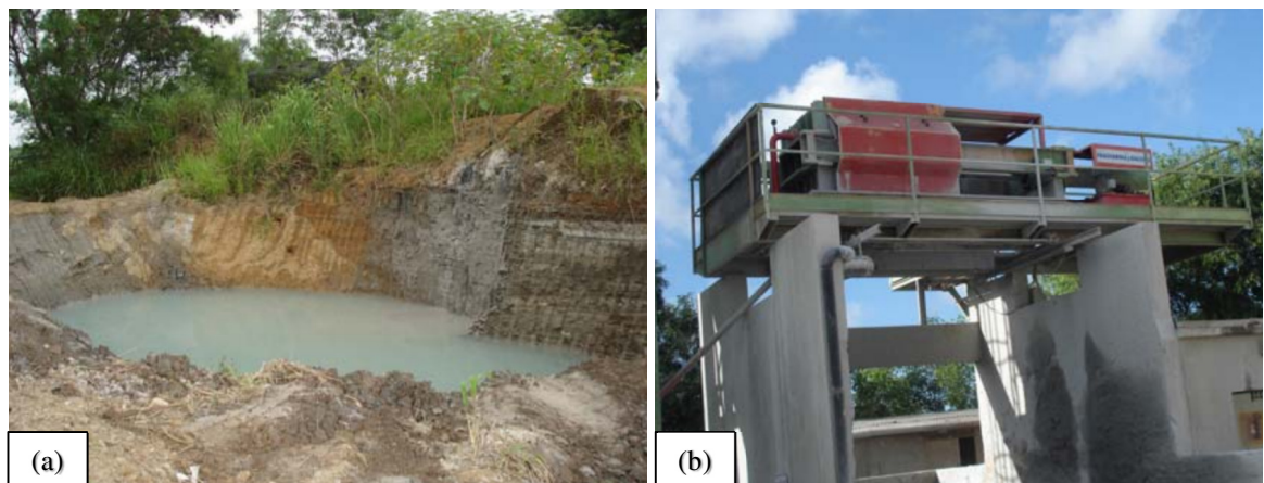
Figura 9 - Lagoa de sedimentação de resíduo (a); Filtro prensa (b)
