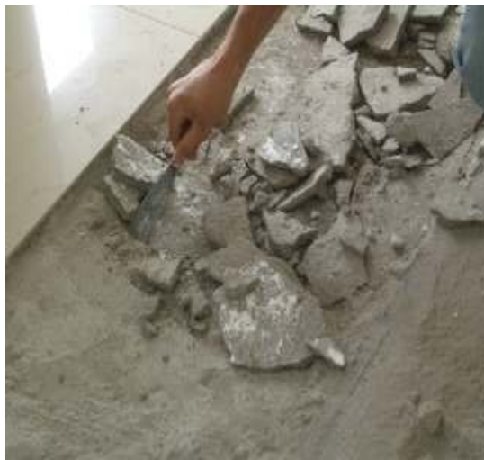
Figura 7 - Desplacamento da camada de contrapiso
