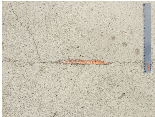
Figura 8 - Tubulação elétrica exposta em camada de contrapiso
