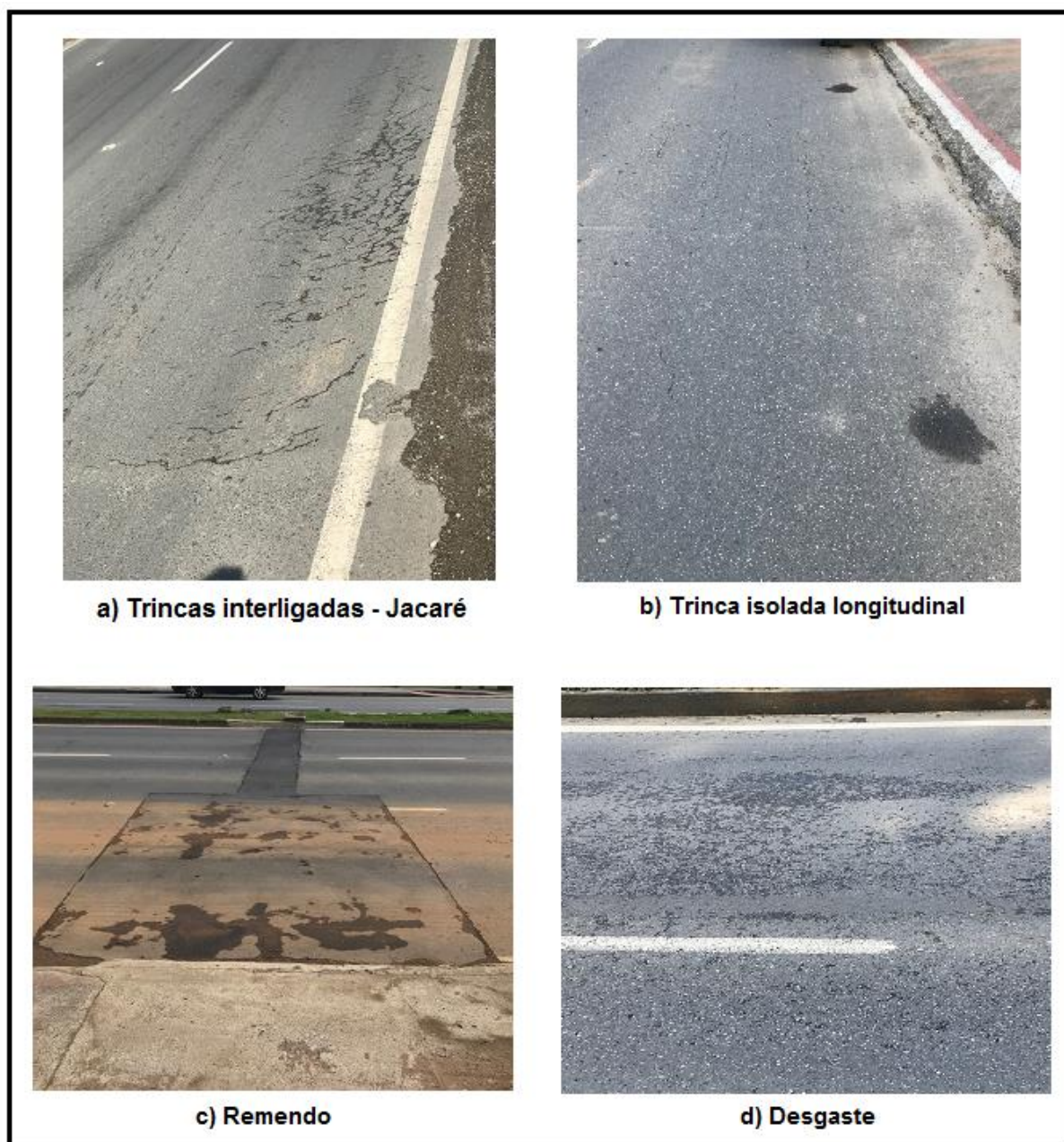
Figura 18 - Tipos de defeitos encontrados na Av. Santos Dumont
