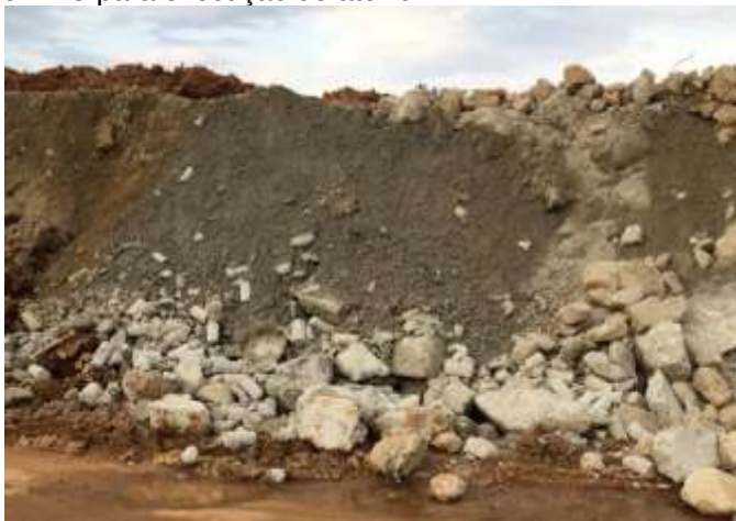
Figura 7 - Utilização de ARC para execução de aterro
