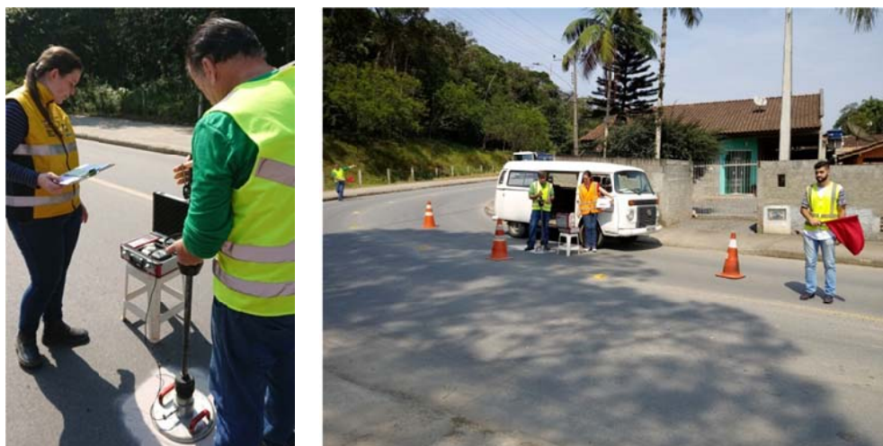
Figura 33 - Equipe para a realização dos testes com LWD
