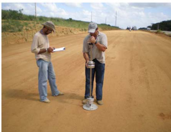
Figura 14 - Realização de ensaio com o LWD.
