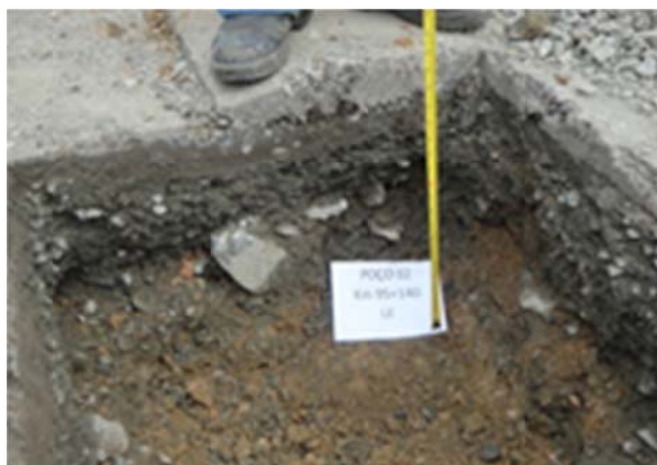
Figura 11 - Poço de inspeção no pavimento
