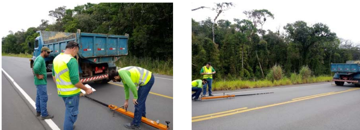
Figura 36 - Ensaaios com a viga Benkelman na Estrada Rio do Morro
