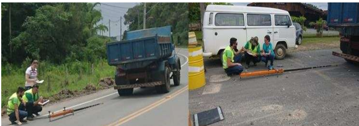
Figura 20 – Realização do ensaio com a viga Benkelman
