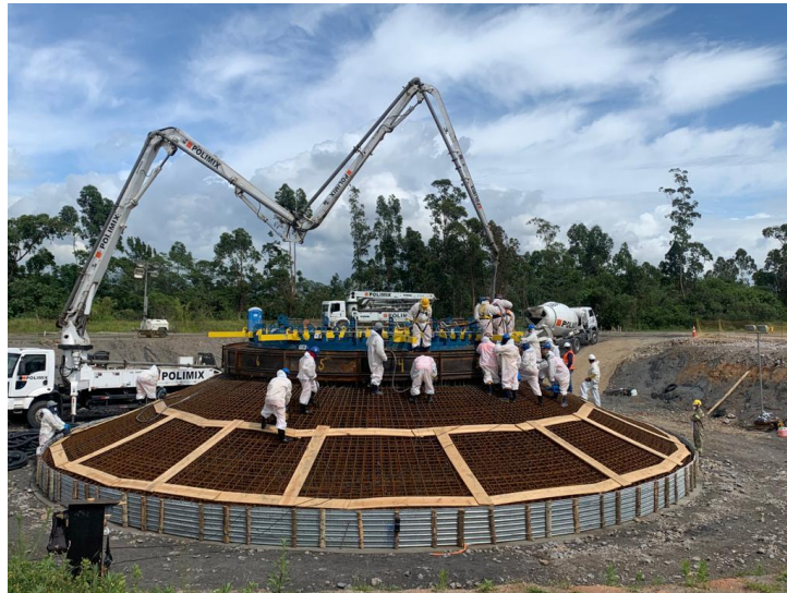
Figura 11: Fundação de uma torre eólica armada
