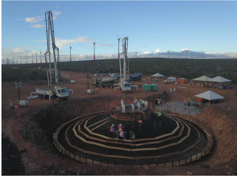
Figura 1: Fundação de um aerogerador de grande porte
