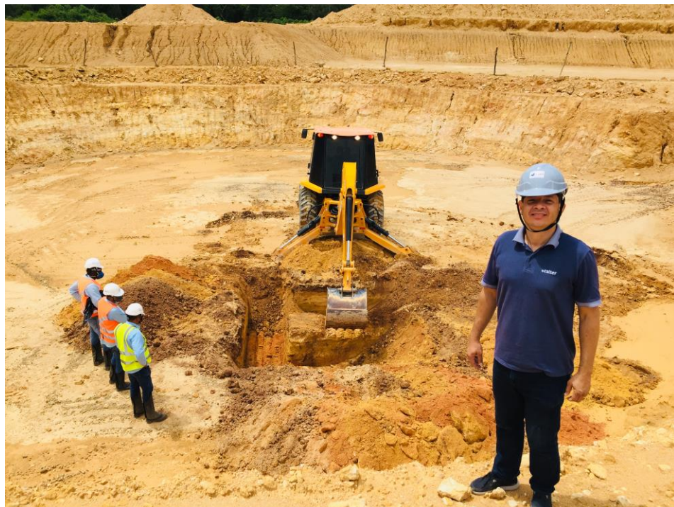
Figura 41: Escavação para retirada da amostra na cota de assentamento da fundação
