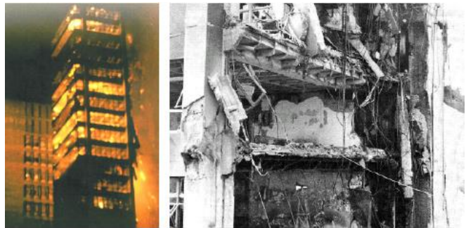
Figura 2 – Colapso parcial devido incêndio do edifício Sede II da CESP – São Paulo, 1987.
