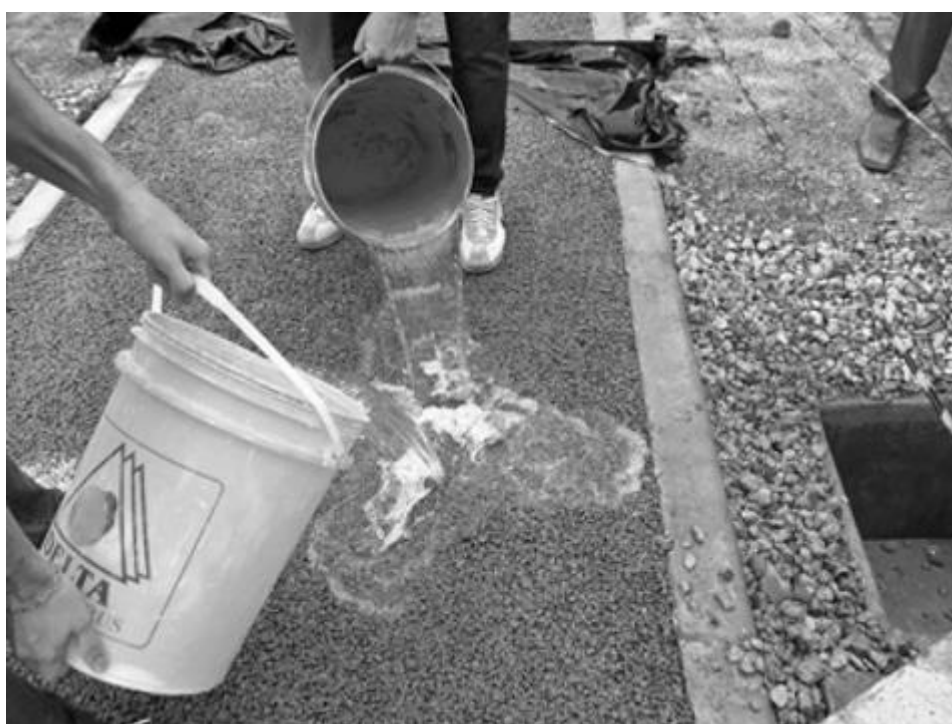
Figura 1 – Pavimento permeável aplicado
