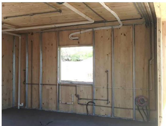
Figura 10. Perfis de drywall fixados na vedação de CLT para área molhada.
