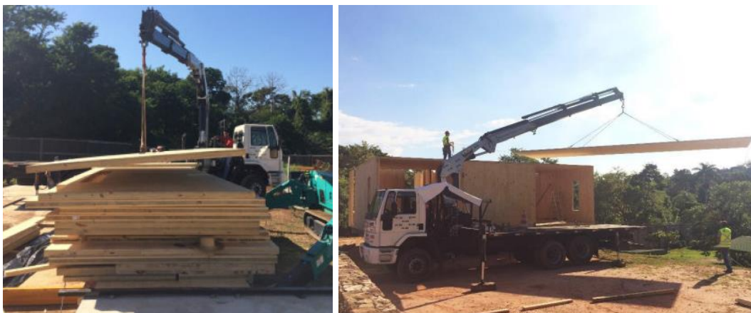
Figura 7. Movimentação dos painéis de CLT na montagem de edificações.
