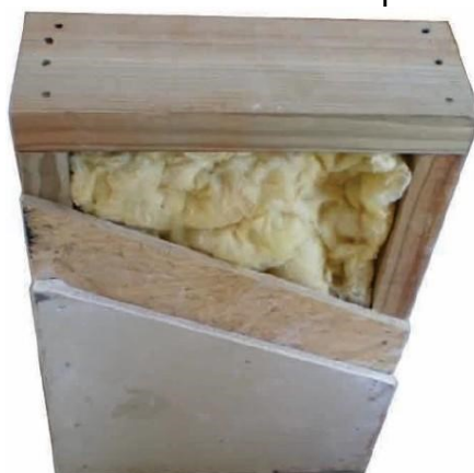
Figura 13 – Isolamento de manta de lã de vidro em quadro estrutural de madeira.
