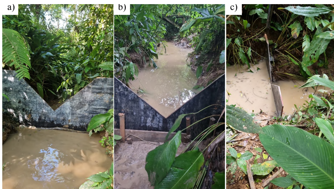
Figura B.2 – Instalação do vertedor provisório; a) Primeira tentativa; b) Segunda tentativa; c) Terceira tentativa.
