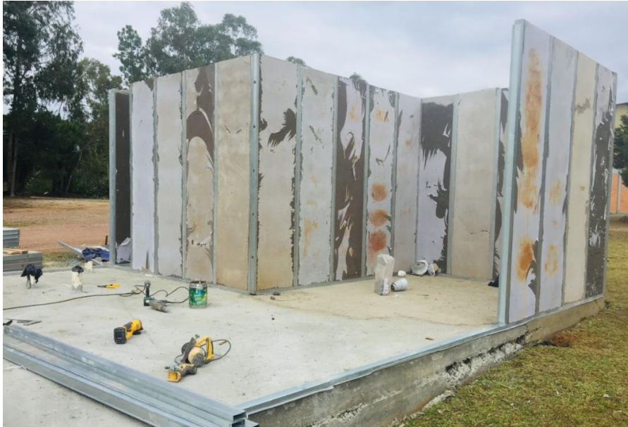
Figura 61 – Utilização de painéis para fechamento de estrutura metálica.
