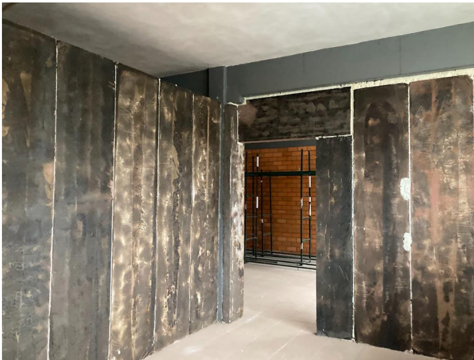
Figura 64 – Utilização de painéis para fechamento de estrutura de concreto pré-moldado em ambiente industrial.
