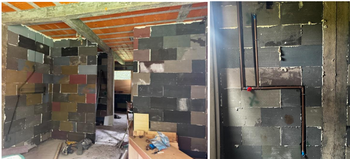
Figura 65 – Utilização de blocos para fechamento de estrutura de concreto armado em ampliação residencial.
