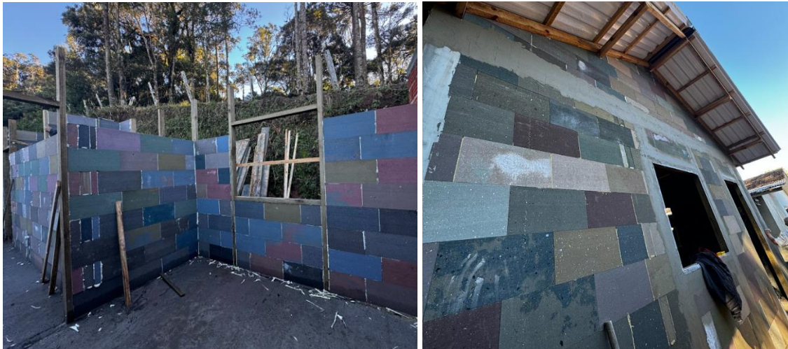
Figura 62 – Utilização para fechamento de estrutura de madeira.
