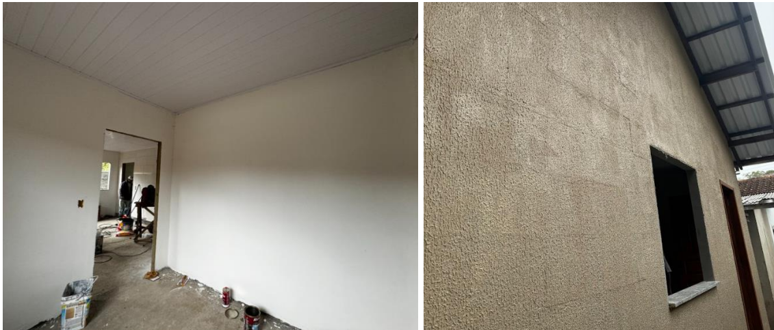
Figura 63 – Utilização para fechamento de estrutura de madeira com acabamento.
