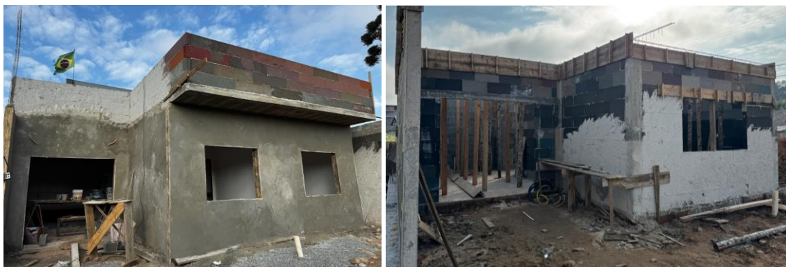
Figura 66 – Condomínio residencial com utilização de blocos para fechamento de estrutura de concreto armado.
