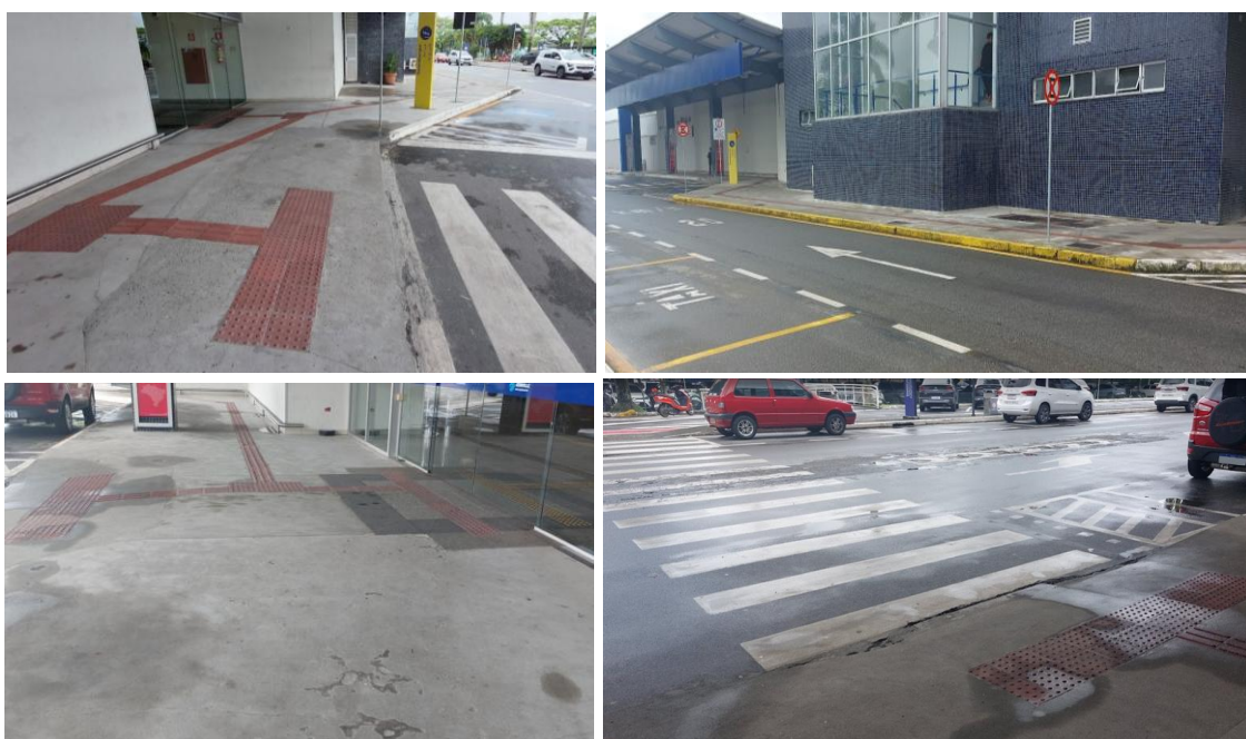
Figura 27 – Infraestrutura para transporte ativo na frente TPS de JOI (S1)
