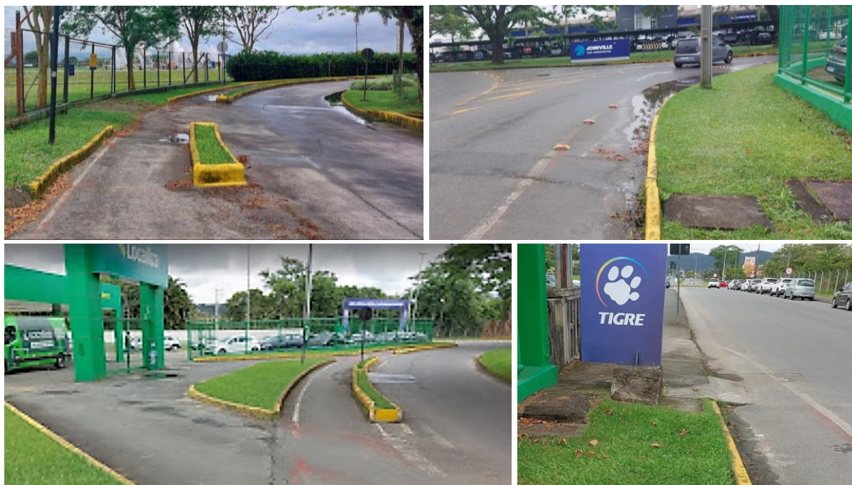
Figura 28 – Infraestrutura para transporte ativo em S2 e S3
