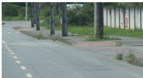
Calçada partilhada entre pedestres e ciclista (S4B) (07/10/24)
