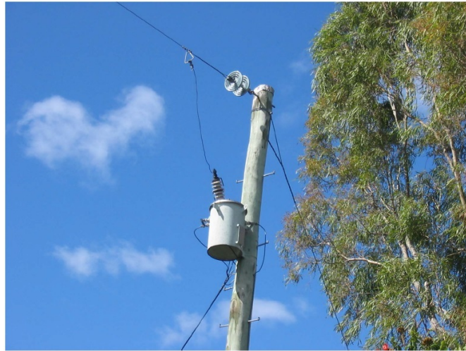
Figura 1 – Instalação da rede de distribuição MRT
