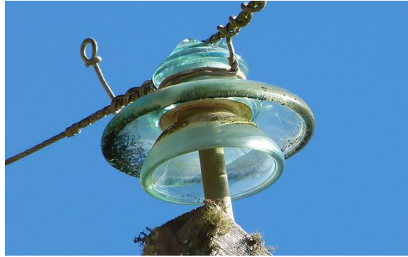
Figura 4 - Isolador com superfície com contaminação incrustada.
