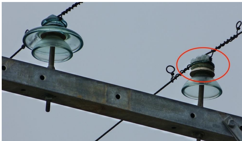
Figura 5 - Isolador parcialmente quebrado por provável vandalismo.
