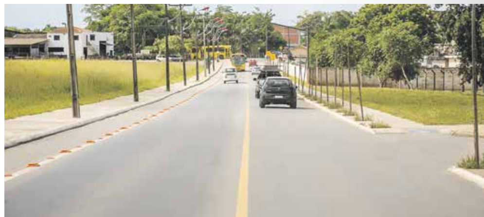
Pavimentação da Rua Tuiuti - 4,5 km
