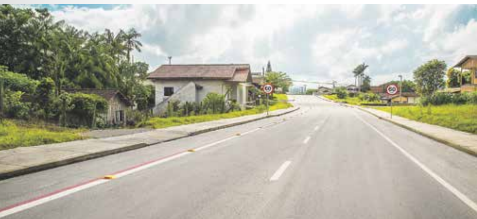
Conclusão do Binário Vila Nova - 3,9 km
