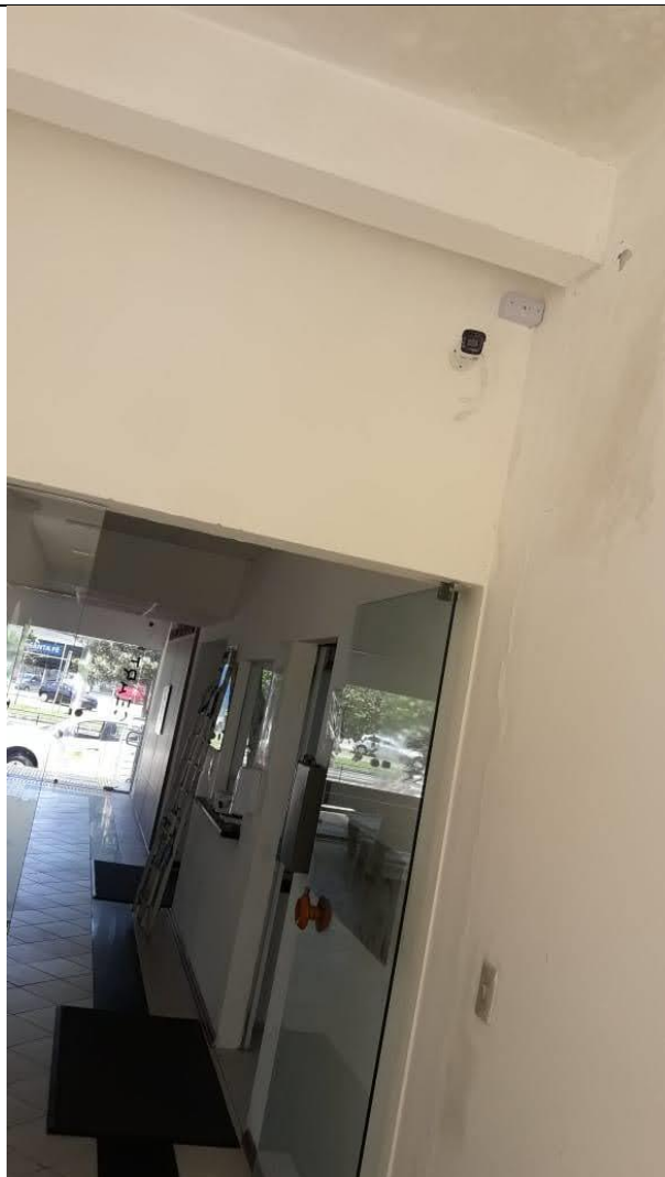
Instalação de câmeras de monitoramento
