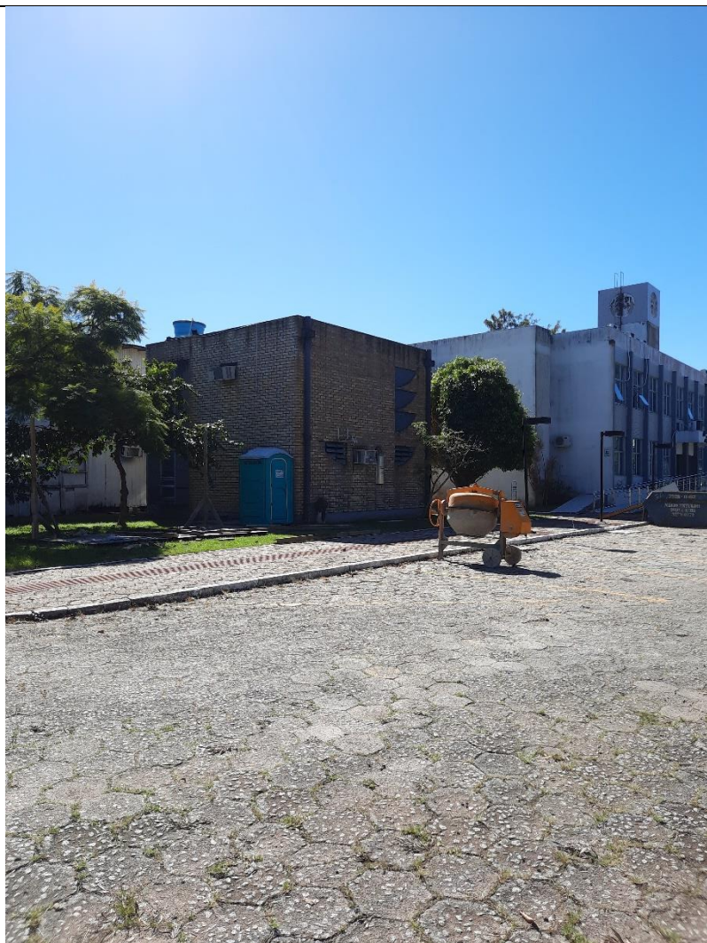
Reforma Laboratório Fotografia - Início
