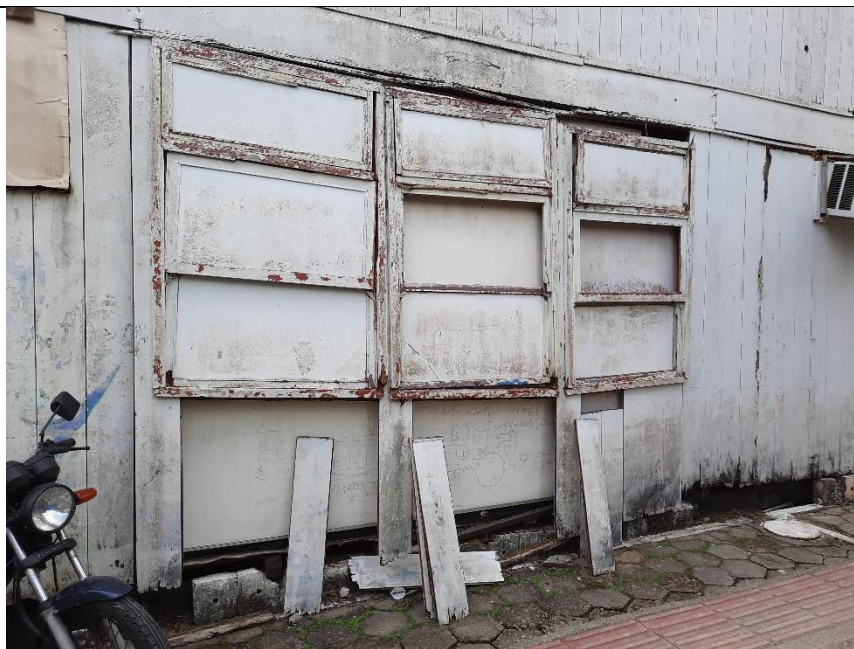
Restauro na edificação de madeira – Troca de madeiramentos (situação anterior)
