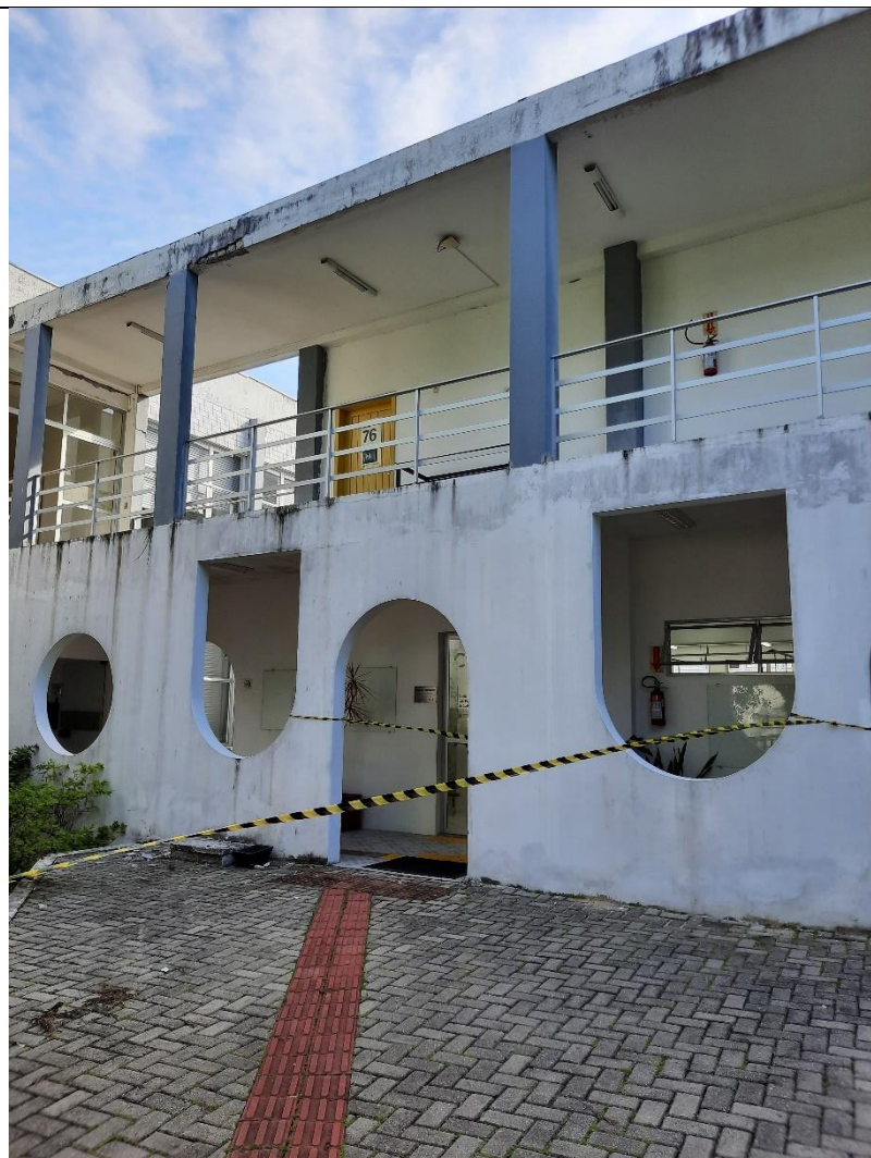
Início da obra de restauro das passarelas de ligação entre os blocos
