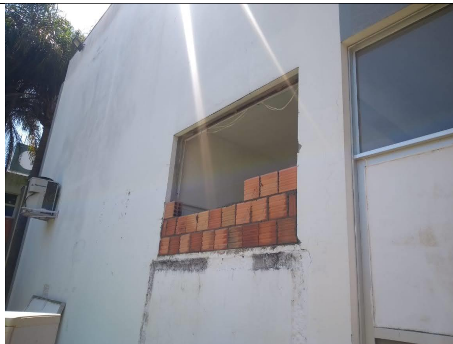
Preparação para instalação do Telão LED
