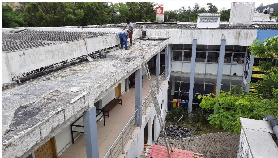
Obra de restauro das passarelas de ligação entre os blocos
