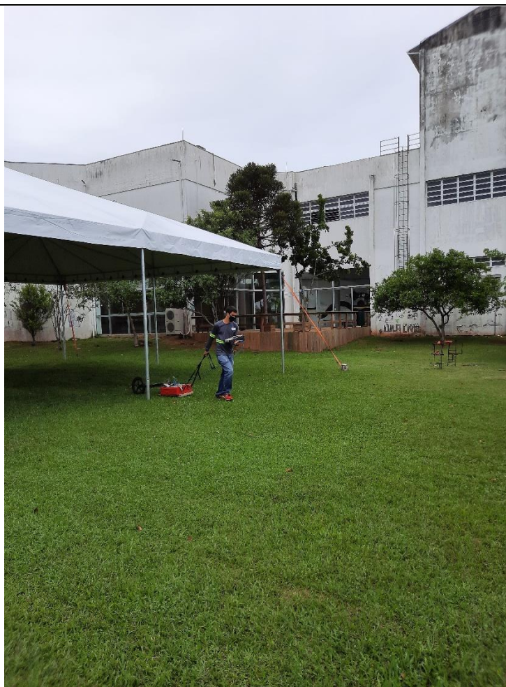
Serviços de radar de penetração no solo – Análise de subsolo de terreno Bloco B Dav
