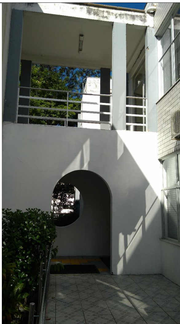
Preocupação constante com a manutenção dos espaços – depois
