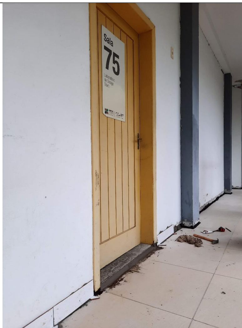
Restauração para conter infiltração ao Ateliê DMO
