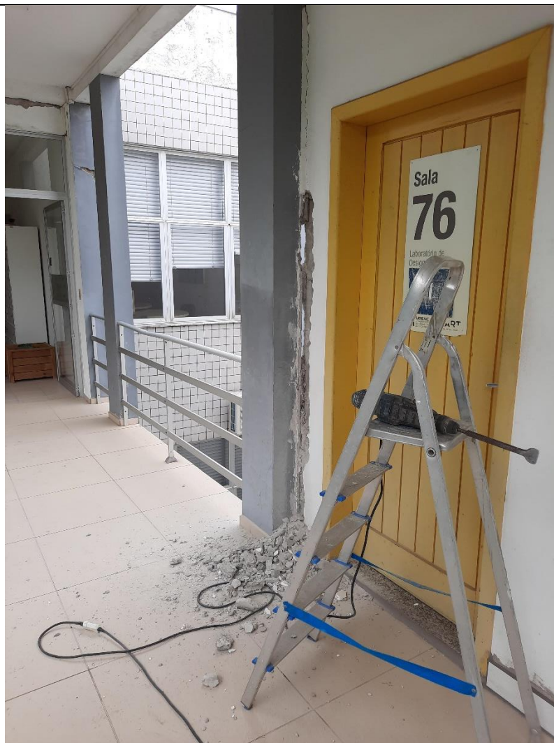
Obra de restauro das passarelas de ligação entre os blocos
