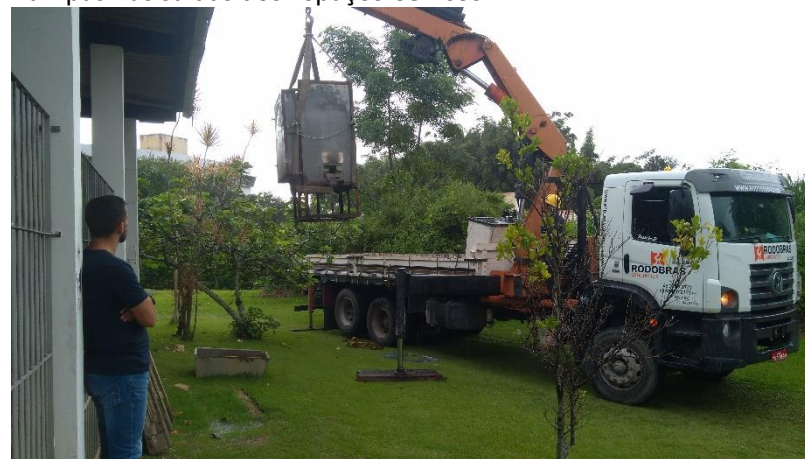
Instalação de forno de cerâmica
