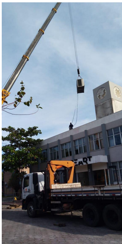
Guindaste para içar Chiller e impermeabilizar contrapiso – sistema de refrigeração do bloco administrativo começou a ser substituído por máquinas individuais Split.
