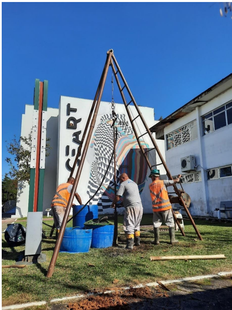
Sondagem do terreno para construção do prédio do Design
