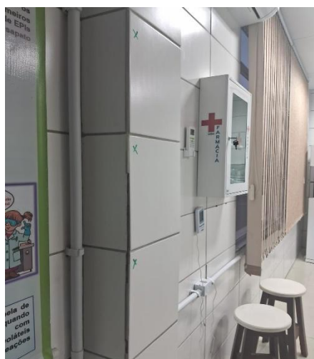
Figura 2. Serviço de manutenção (a) Rede hidráulica sem água; (b) Troca de bocós de bunsen danificados na saída de gás; (c) Desplacamento das placas de azulejo da coluna estrutural do laboratório; (d) Instalação do suporte de vidrarias.
