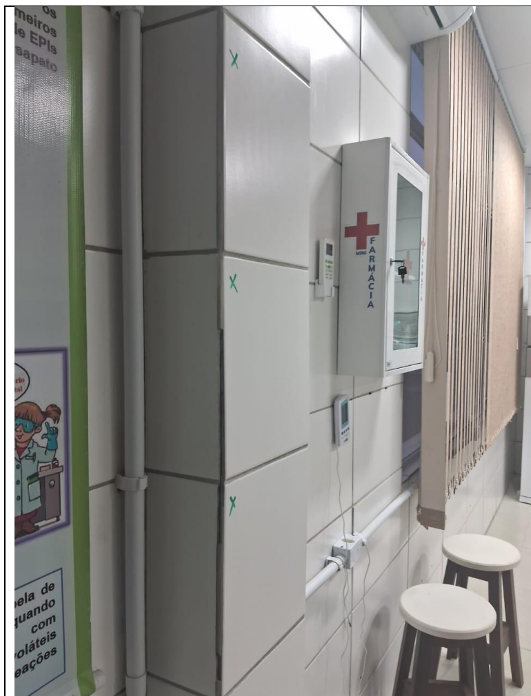
Figura 3 – peças de azulejo com deslocamento no laboratório s110.
