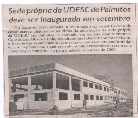
Figura 2: Registros da construção do Prédio próprio em Palmitos/SC, 2006.
