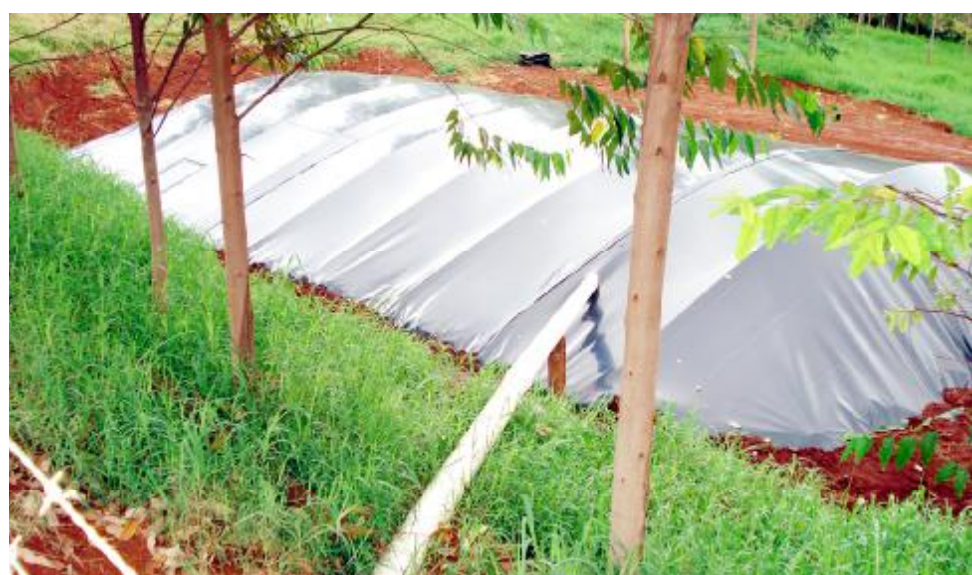
Reservatório escavado e revestido em PEAD – Polietileno de Alta Densidade
