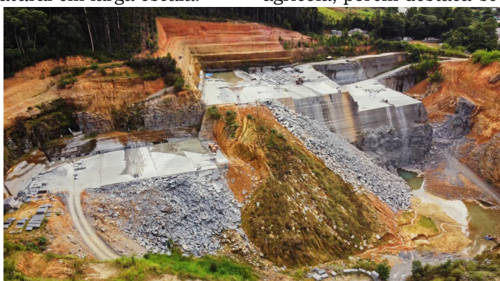
Figura 1. Extração da rocha varvito na central de britagem Castelinho, em Trombudo
