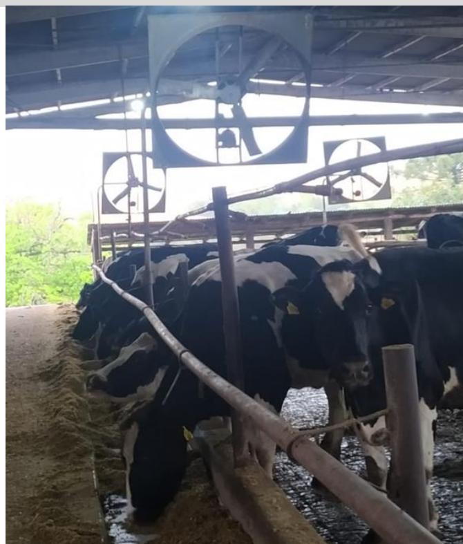
Figura 1: Sistema de resfriamento de bovinos leiteiros com ventilação associada a aspersão na linha de cocho.
