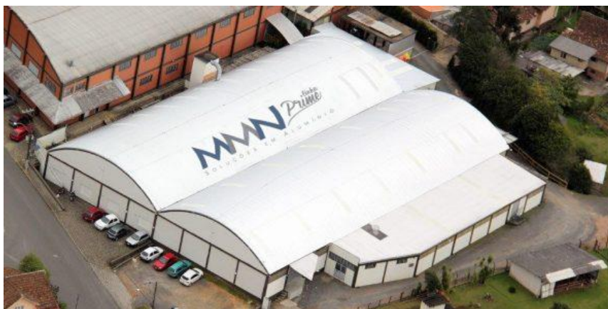
Figura 1. Vista aérea da Empresa. Fonte: Empresa MMN (2021)
