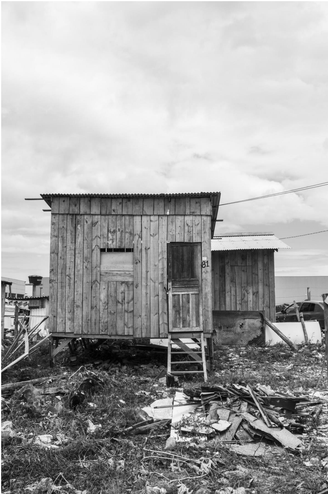
Casa feita com o processo de autoconstrução, na ocupação Nova Esperança - Palhoça, SC. Foto: Leonardo Bandeira.
