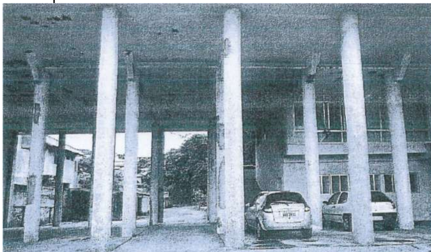
Figura 8 – Vista da área de pilotis com acesso aos fundos do terreno, a partir da entrada do edifício. Foto do período do tombamento, patologias de pilares e laje do 1º pavimento são aparentes.
